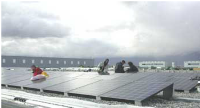
Vue des panneaux en cours de montage
